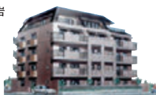
メゾン・ヴァンバール音羽町 (平成11年完成/全12戸)
