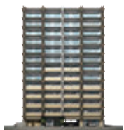
メゾン・ヴァンバール東静岡 (平成26年9月完成/全49戸)
